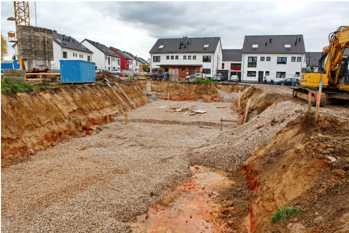
Baustelle Neubaugebiet Niederforstbach (?)
