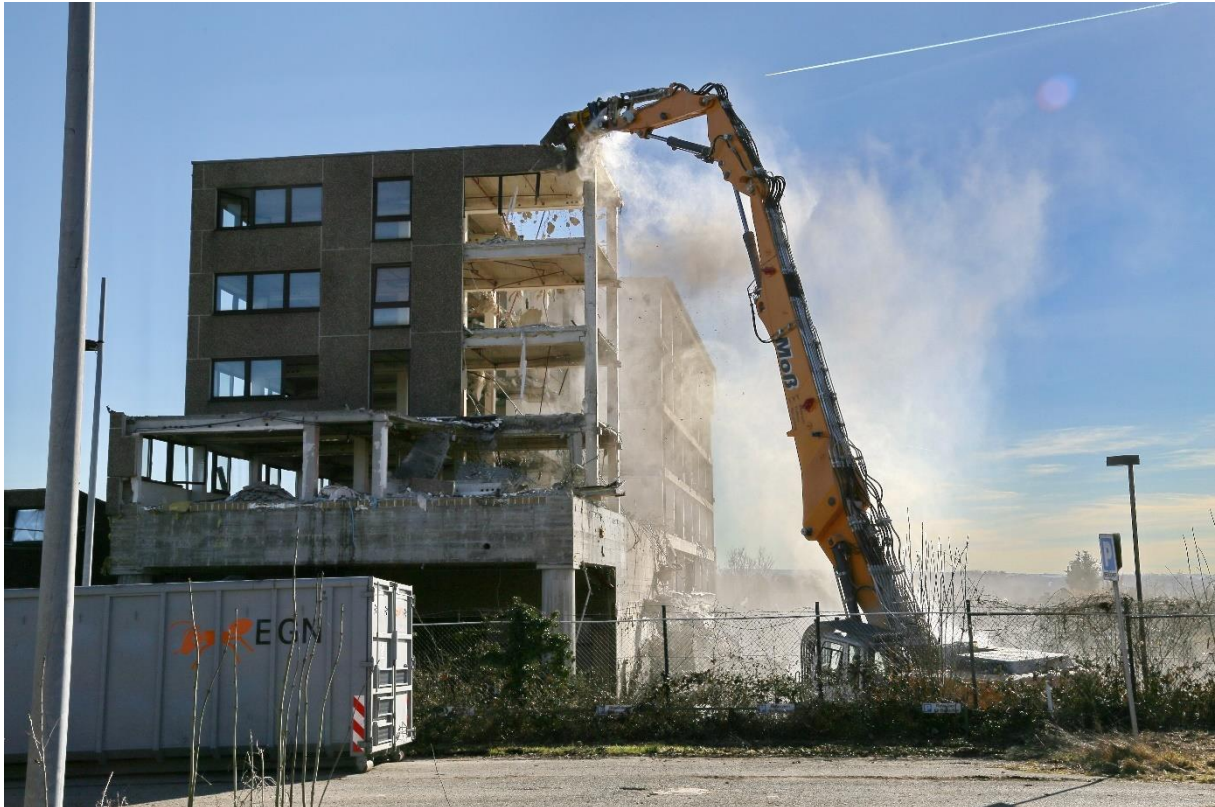
Abriss der Tuchfabrik Becker (2018)
